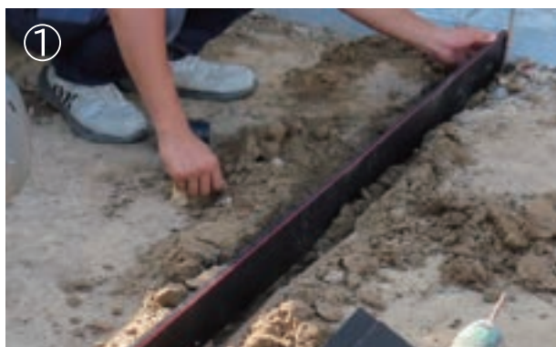
① 水糸位置に合わせて溝を掘り、ネオエッジを仮設置します。
