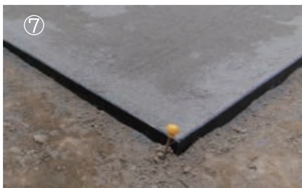
⑦ 状況により、砂、防草シート等を施工します。
