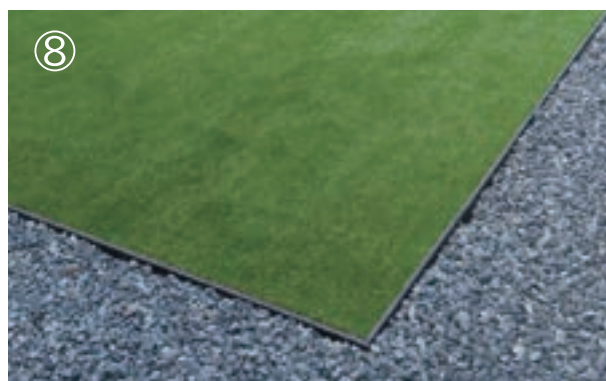
⑧ 人工芝、天然芝、砂利、ウッドチップ等を施工して完成です。
