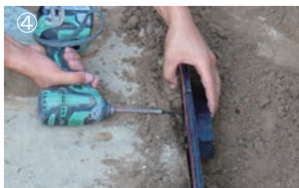
④ ネオエッジとジョイント材をビス固定し連結します。
