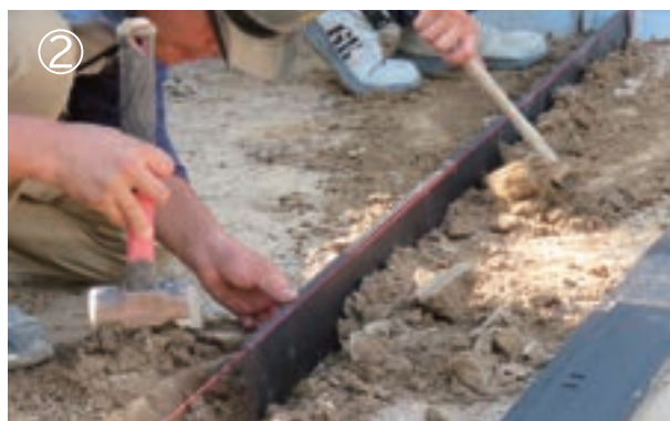
② 水糸を基準にしながらハンマー等で軽く叩いてレベル調整します。
