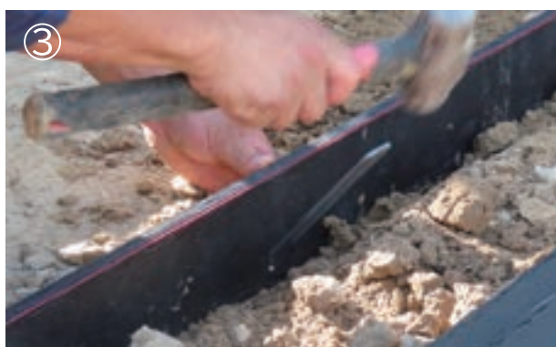
③ コの字ピンを斜めに打込みしっかり固定します。
