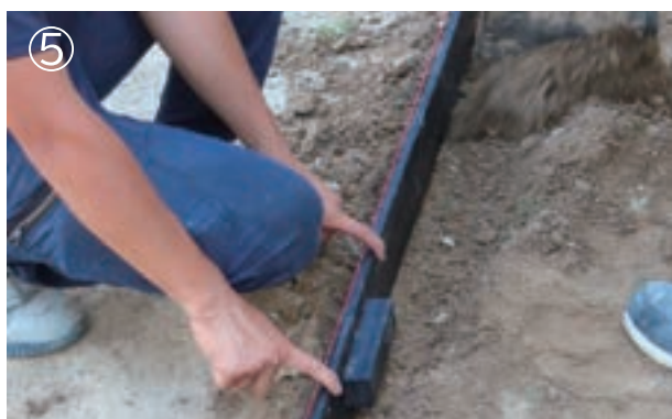
⑤ 土を埋め戻し、踏み固めます。
