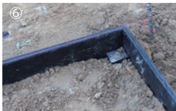
⑥ コーナー部はジョイント材を縦に打込み固定します。
