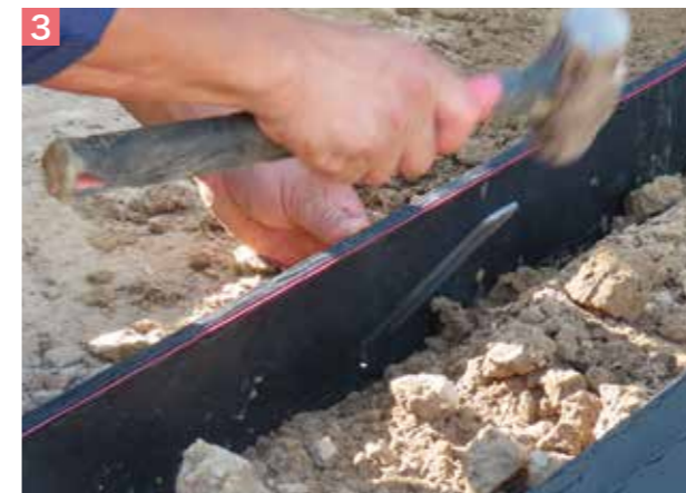
3 コの字ピンを斜めに打込みしっかり固定します。
