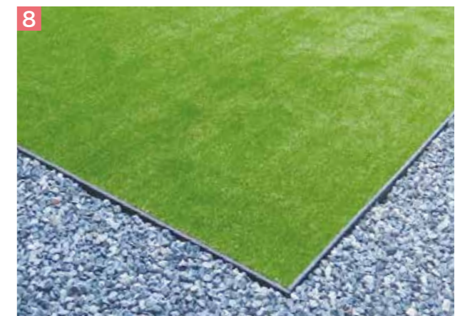
8 人工芝、天然芝、砂利、ウッドチップ等を施工して完成です。
