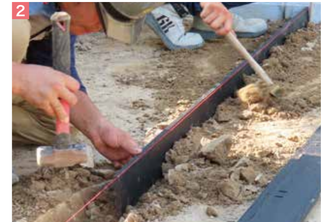
2 水糸を基準にしながらハンマー等で軽く叩いてレベル調整します。
