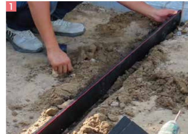
1 水糸位置に合わせて溝を掘り、ネオエッジを仮設置します。
