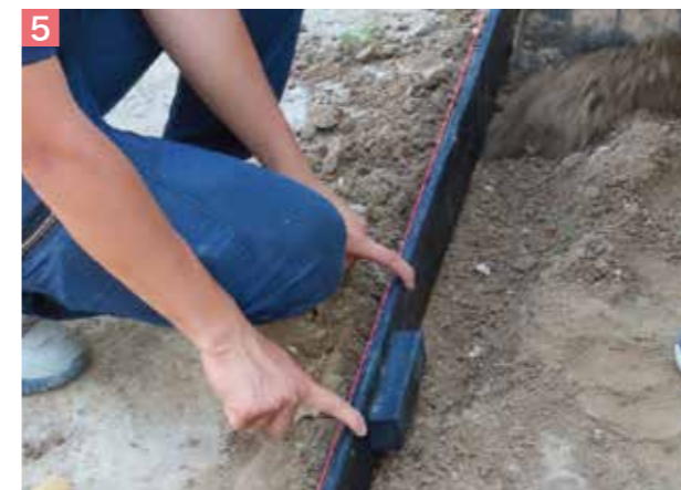
5 土を埋め戻し、踏み固めます。
