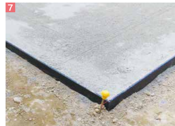
7 状況により、砂、防草シート等を施工します。
