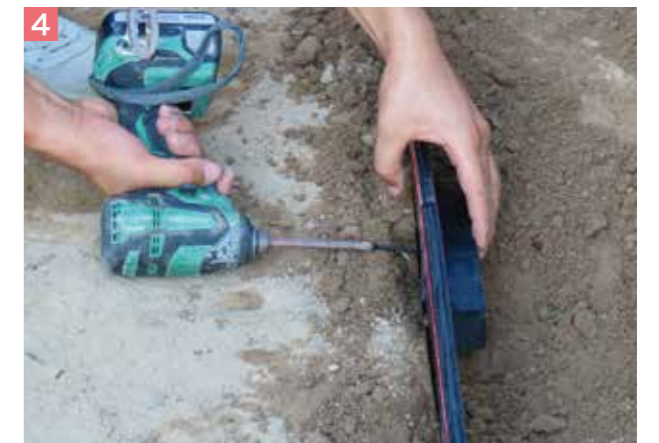
4 ネオエッジとジョイント材をビス固定し連結します。
