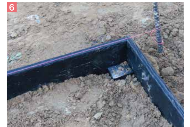
6 コーナー部はジョイント材を縦に打込み固定します。
