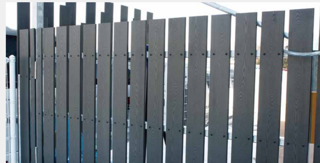
●パネル / F1 ●カラー / ノアール ●特記 / 標準外施工
